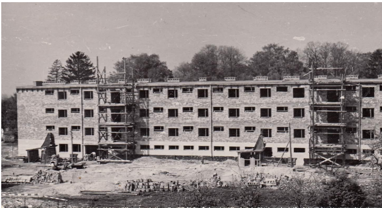
Zdj. 4 Budowa internatu męskiego
