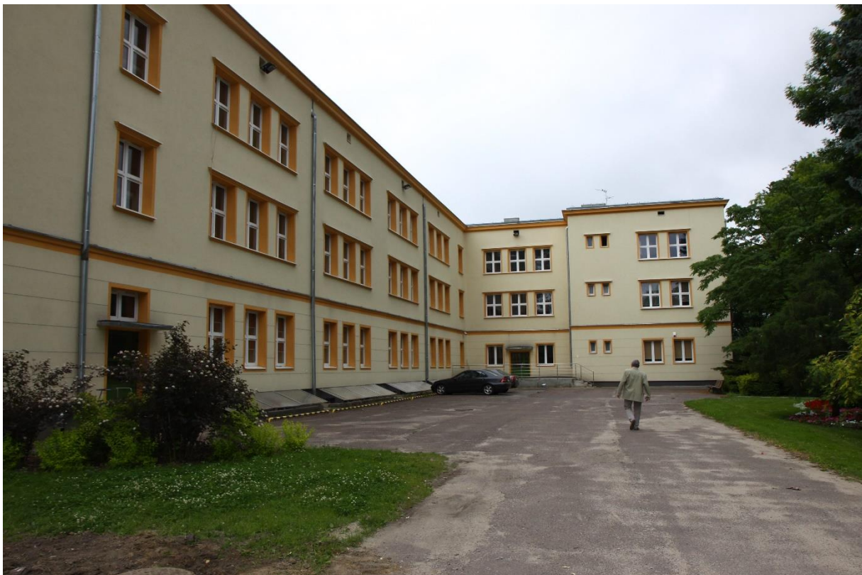
Parking wewnętrzny przy gmachu głównym
